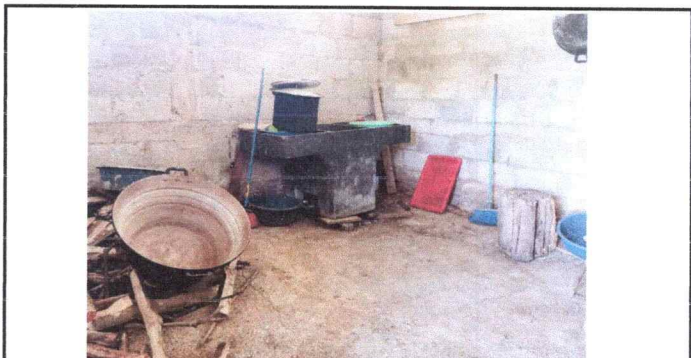
Foto 4: Mantenimiento de piso de la cocina
