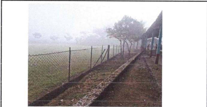
Foto 1: Mantenimiento de cerco o muro perimetral
